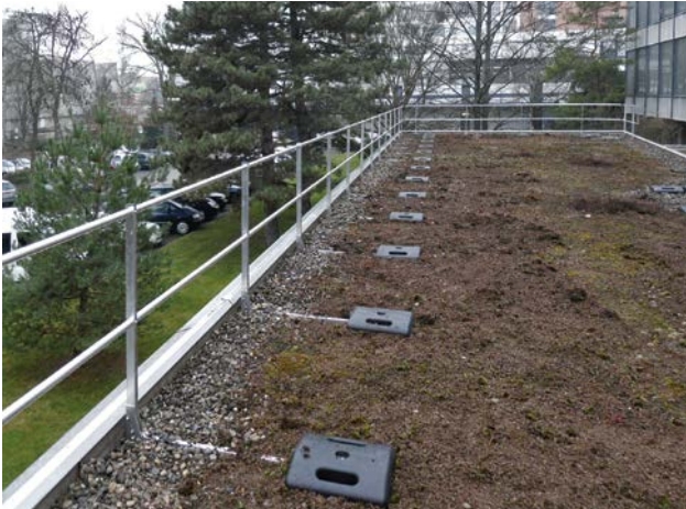
Bild 1 Kollektivschutz bietet optimale Sicherheit am Dachrand
