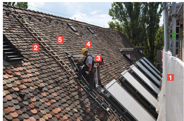
Bild 12 Arbeitsplatz-Positionierungssystem auf einem geneigten Dach
