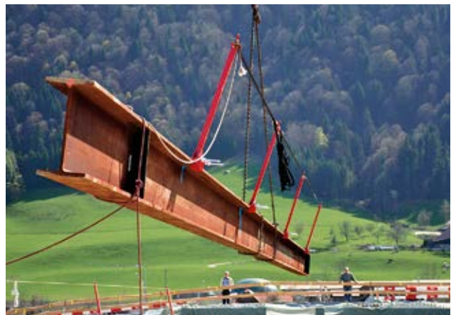
26 Gut geplant: Ein Stahlträger wird mit dem bereits vormontierten Lifeline-System auf der Baustelle eingehoben.
