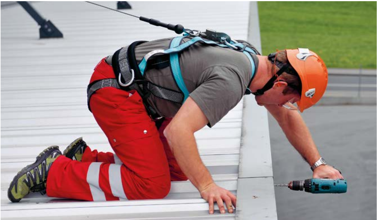
18 Arbeiten an einer Absturzkante.
