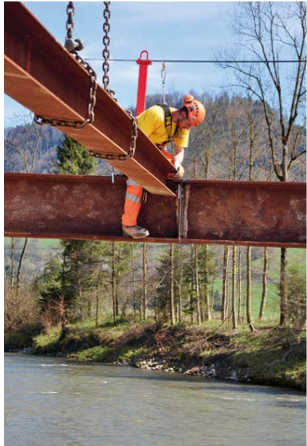
25 Montage einer Stahlkonstruktion mit Sicherung an einer horizontalen Lifeline.
