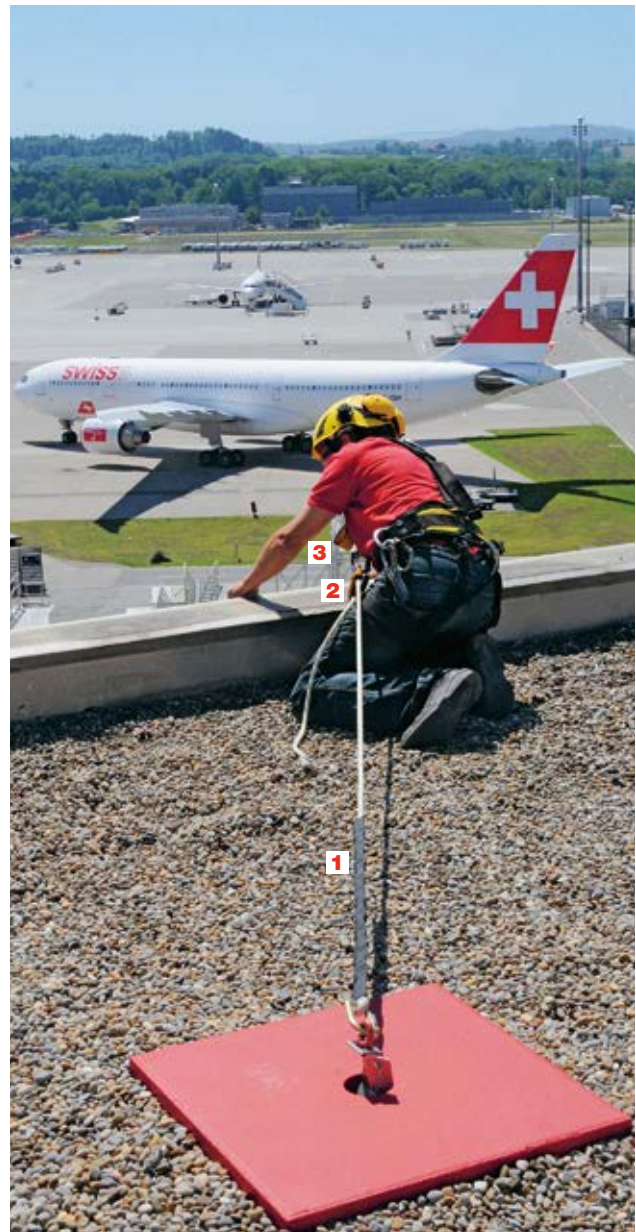
13 Auf einem Dach arbeitende Personen, die durch Auffanggurten an einem Sicherungsseil gesichert sind.
