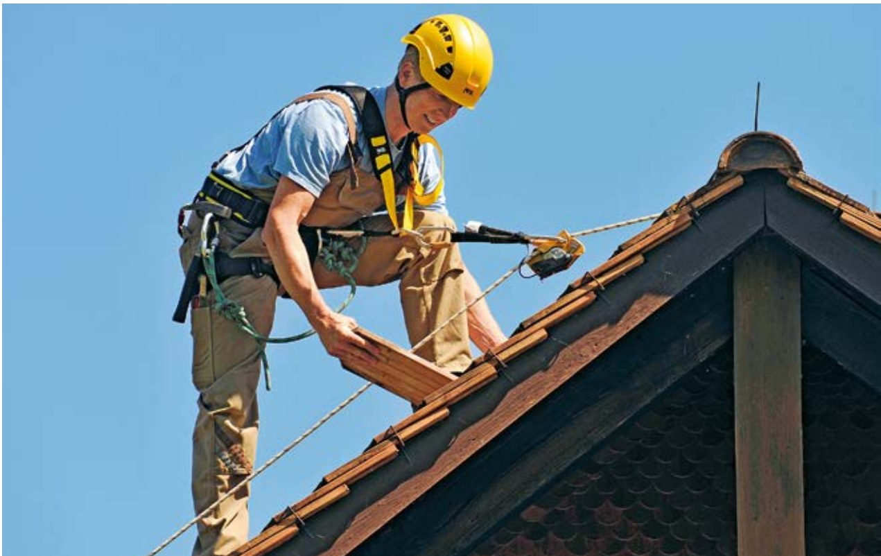
9 Reparaturarbeiten auf einem Dach, Sicherung mit Auffanggurt und Sicherungsseil.
