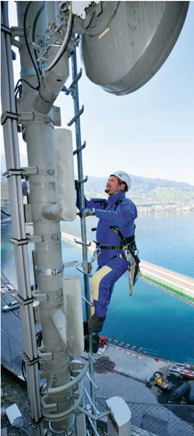
14 Mit einem Steigschutz an der Mittelschiene einer ortsfesten Leiter gesicherter Monteur.
