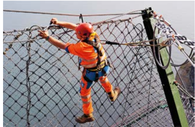
8 Sicherung mit Auffanggurt und Halteseil.
