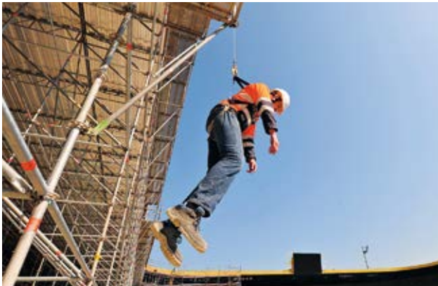
19 Eine abgestürzte Person muss innerhalb von 10 bis 20 Minuten durch Mittel vor Ort geborgen werden, ohne weitere Gefährdung des Verunfallten und des Retters.
