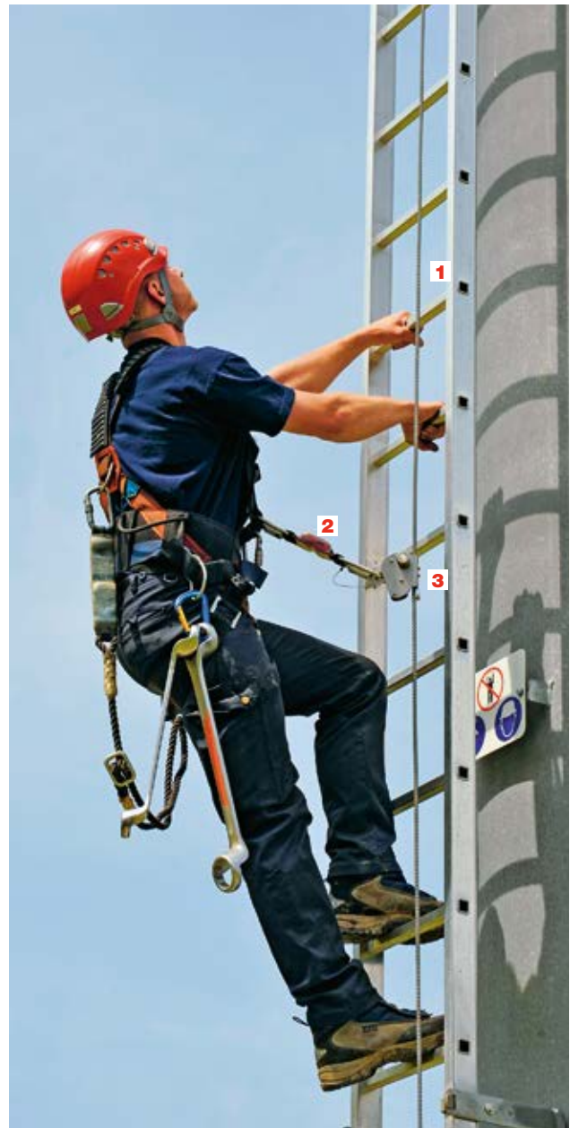
16 Durch Auffanggurt an mitlaufendem Auffanggerät gesicherte Person.
