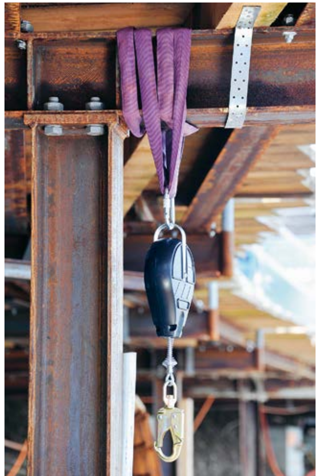
23 Anschlagen des Sicherungsseils an einem tragfähigen Teil einer Tragkonstruktion.
