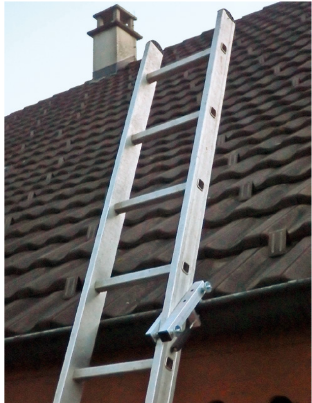
Bild 19 Sicherer Zugang aufs Dach für Arbeiten von kurzer Dauer; Leiter am Dachrand gesichert
