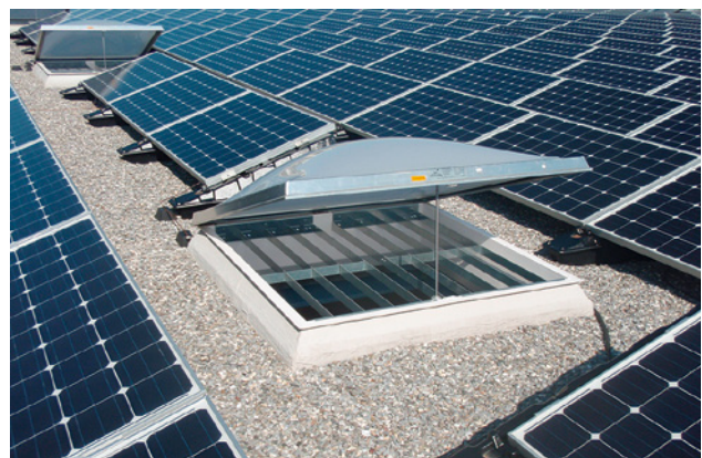
Bild 1 Oblicht, mit einem Gitter gegen Durchbruch gesichert
