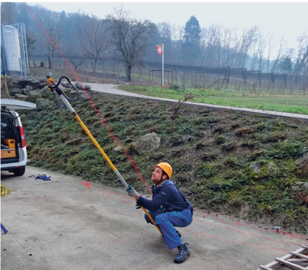
Bild 17 Seilwurfsystem mit Industrieschleuder
