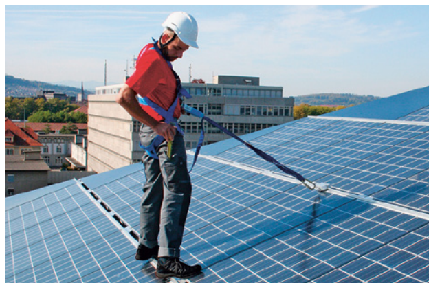
Bild 12 Anschlageinrichtung, in Solaranlage integriert
