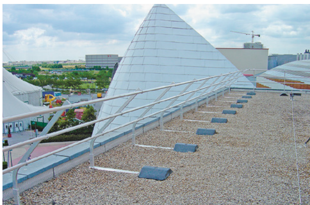
Bild 6 Seitenschutz ohne Dachhautdurchdringung – temporär und permanent einsetzbar
